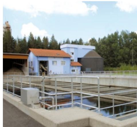
In den Nachklärbecken setzt sich Schlamm ab, der aus der Bakterienmasse besteht. Aus diesem wird im Faultrum im Hintergrund Biogas erzeugt.
