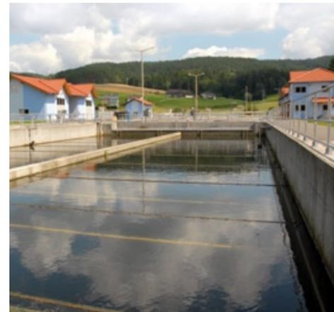
Das gereinigte Abwasser aus dem Nachklärbecken fließt in die Feldaist. Es wird eine Reinigungsleistung bis zu 99 % erreicht.
