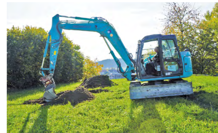
Vorbereitungsarbeiten für das neue Hochwasserschutzbecken im Norden von Freistadt.
