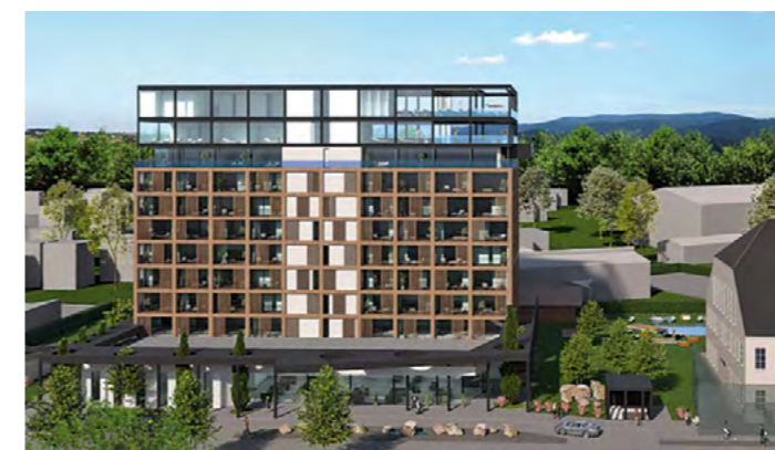
So wird das Vier-Sterne-Superior-Hotel in etwa aussehen. Die unmittelbar anschließende alte Versteigerungshalle will der Investor zu einem überdachten Marktplatz umgestalten.
