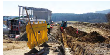
Der Leitungs- und Straßenbau startete am 9. November 2020, im Herbst soll das 13,4 ha große Areal fertig erschlossen sein.
