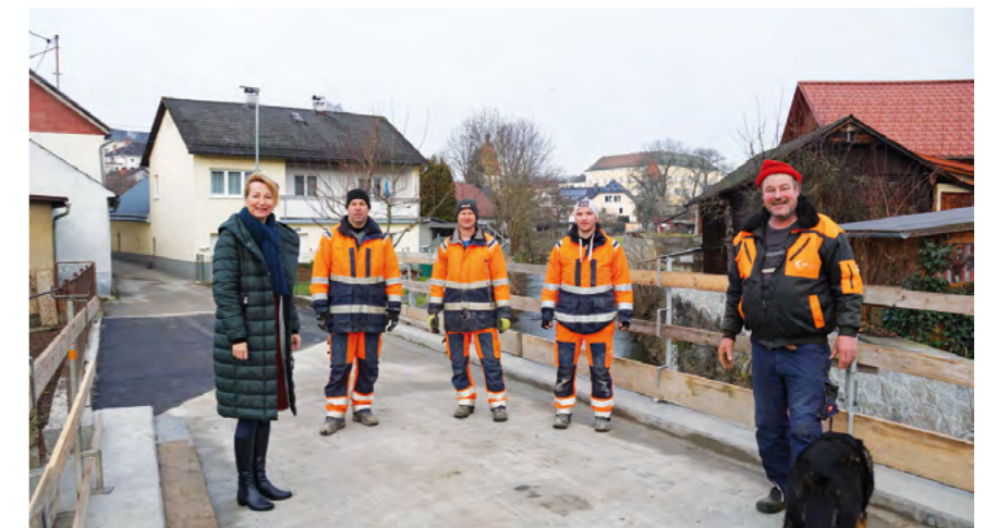
Die Sanierung der Brücke Tanzwiese ist bereits erfolgreich abgeschlossen.
