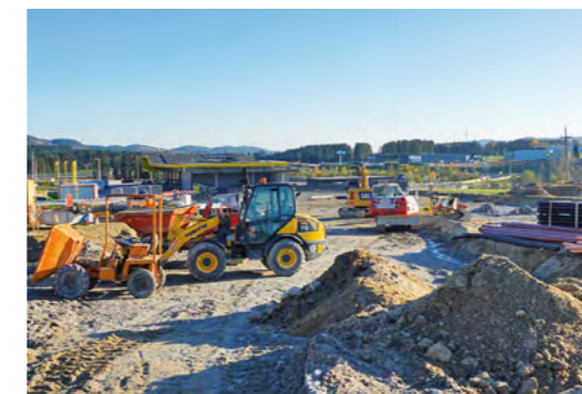
Die Park&Ride-Anlage neben dem ÖAMTC soll im Mai fertig sein.
