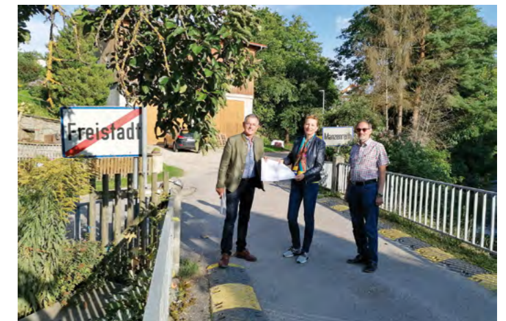
Gelungene Zusammenarbeit an der Gemeindegrenze: Bürgermeisterin Elisabeth Teufer, Lasbergs Bürgermeister Josef Brandstätter und Gemeinderat Karl Prieschl bei der Besichtigung der sanierungsbedürftigen Brücke Tanzwiese.
