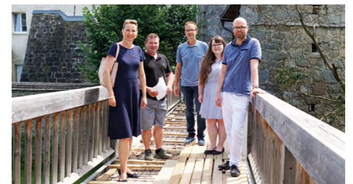
Lokalaugenschein: Bürgermeisterin Elisabeth Teufer, Stadtsamtsleiter Florian Riegler, Bauabteilungsleiterin Bianca Scherb und Sachbearbeiter Manfred Hießl begutachten gemeinsam mit dem Statiker den Scheiblingturm-Übergang.
