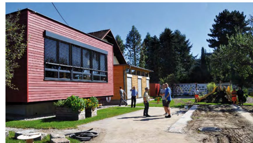
Der Kindergarten Sonnenhaus wird aufgrund des hohen Bedarfs an Betreuungsplätzen um zwei Gruppen erweitert.
