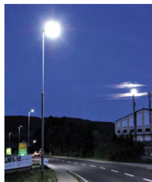
Zwischen 2014 und 2016 wurde die Straßenbeleuchtung auf LED-Technologie umgerüstet.
