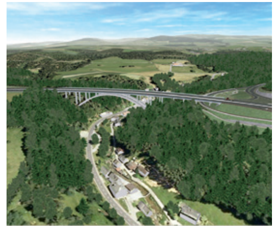
Eines der imposantesten Bauwerke entlang der gesamten S 10 wird sicher die - mit rund 350 Metern Spannweite, zirka 60 m Höhe und gut 31 m Breite = 4 Spuren plus Pannestreifen - überaus gewaltige Bogenbrücke über den „Graben“ werden, mit ihrem Bau wird noch heuer begonnen. „Dimen- sionen und architektonische Eleganz lassen sie bestimmt zu einem der neuen Wahrzeichen unserer Stadt werden“, ist Bürgermeister Christian Jachs überzeugt.
