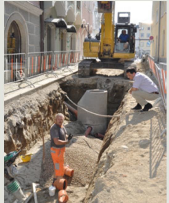
Baustellenvisite in der Samtgasse! „Dankeschön, Burschen, dass ihr bei Hitze wie bei Regen derart fleißig bei der Arbeit seid, damit wir schnell genug fertig werden!“ Bürgermeister Christian Jachs ist mit dem Engagement seiner Bautrupps mehr als zufrieden.
