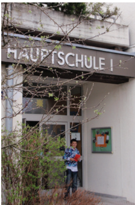
Von außen noch halbwegs ansehnlich, innen aber seit Jahren ein Sanierungsfall. Die Doppelhauptschule in Freistadt, deren Ausbau nun ebenfalls konkret in Angriff genommen wird.
