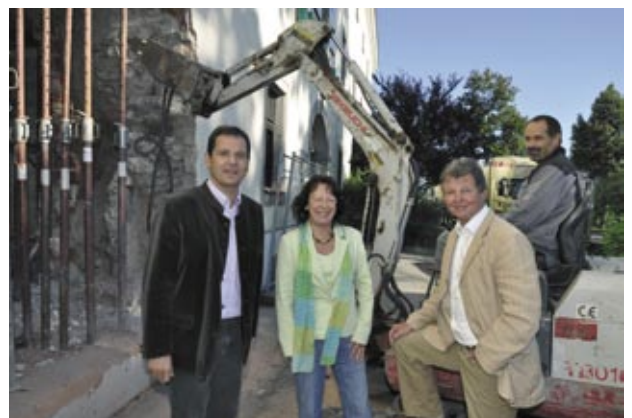
In der Brauerei wird bereits emsig gewerkt! Bürgermeister Christian Jachs, Kulturstadträtin Heidi Kreischer und Ewald Pöschko bei einer ersten Baustellenbegehung!
