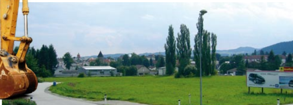
Im Bereich zwischen Uni-Markt und Lidl sollen drei neue Märkte entstehen.
