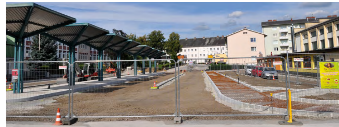
Die Generalsanierung des Busterminals Stifterplatz ist voraussichtlich Mitte Oktober abgeschlossen.
