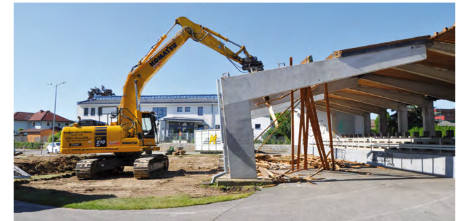
Damit die Außenspielfläche des Kindergartens Bahnhofstraße erweitert werden kann, wurde die Außentribüne der alten Versteigerungshalle vergangenes Jahr abgerissen.
