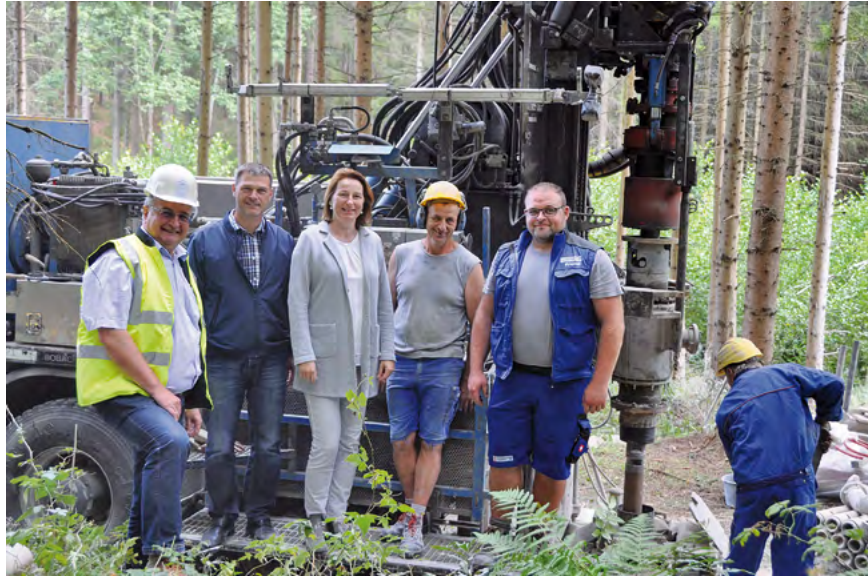
Bohrungen bis zu 210 m in die Tiefe! Das konnten sich Bürgermeisterin Elisabeth Paruta-Teufer und Stadtrat Thomas Koller nicht entgehen lassen und besuchten die Experten in der Zelletau.
