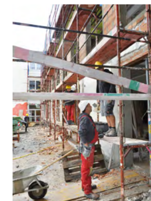
Auf der Baustelle der Neuen Mittelschule wird fleißig gearbeitet.
