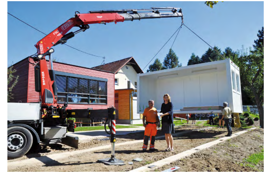
Beim Kindergarten Sonnenhaus in der Klostersgasse wurde ein Container für die zusätzliche Kindergartengruppe aufgestellt.
