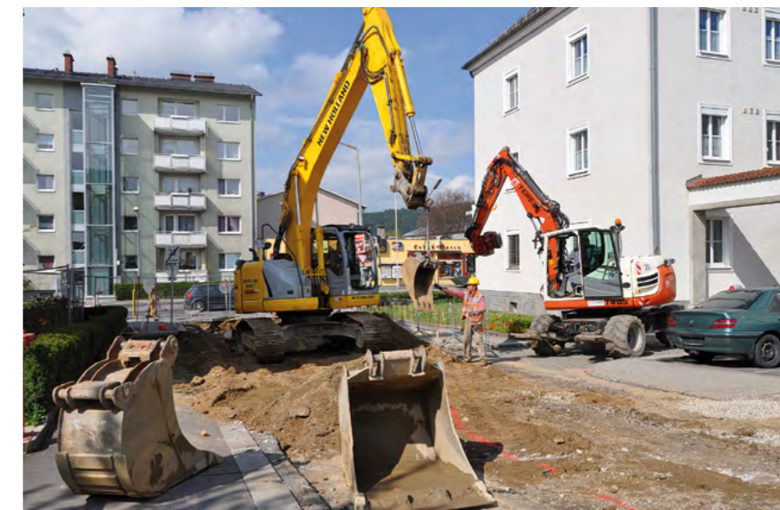
Zehn Straßen wurden vergangenes Jahr in Schuss gebracht. Auch heuer steht ein intensives Straßenbaujahr bevor.
