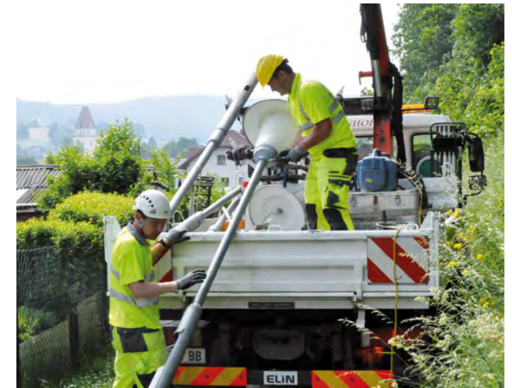
Voller Einsatz! Ein Großteil der Umrüstung der Straßenbeleuchtung auf LED ist geschafft.
