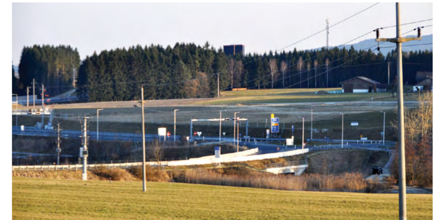
Von der B 38 Böhmerwaldstraße direkt auf die S 10: Hier wird die Westtangente an die Schnellstraße angeschlossen. Autofahrer sparen sich einen Umweg von 1,5 Kilometern.
