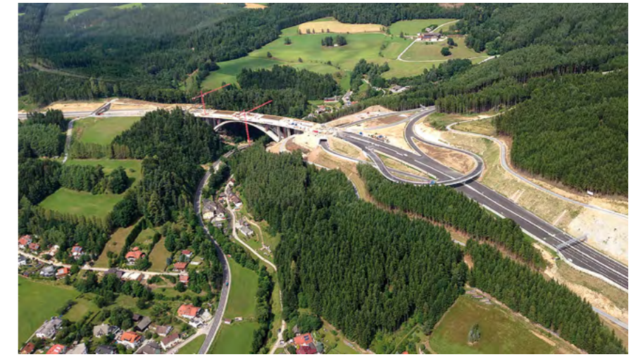
6 Kilometer, 13 Brücken, 2 Tunnel, 142 Millionen Euro und 3 Jahre Bauzeit: Seit fünf Monaten ist die Umfahrung Freistadt für den Verkehr freigegeben. Ende dieses Jahres wird die gesamte S10 eröffnet. (Foto: Walter Mittermüller)
