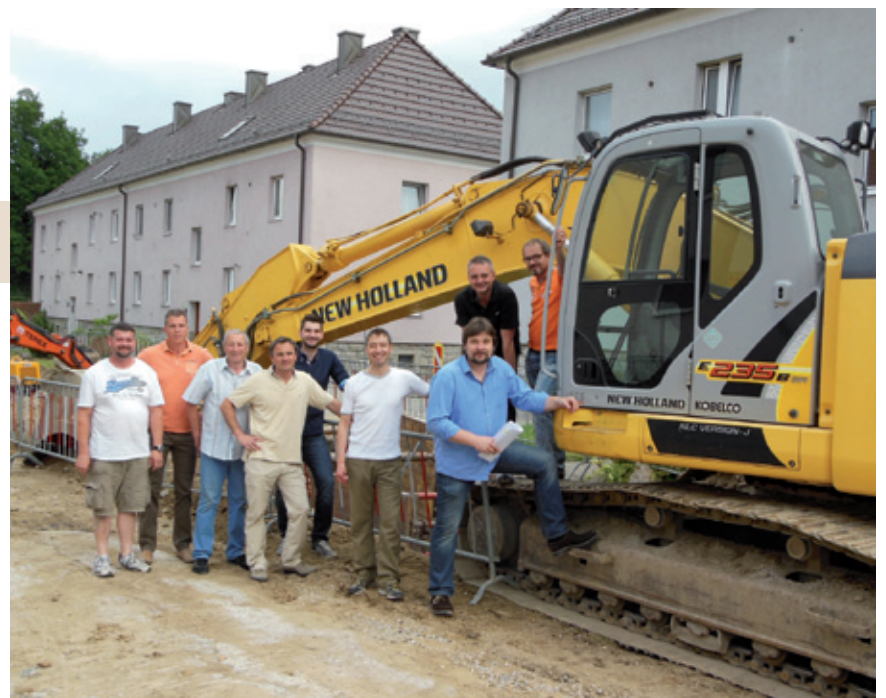
Der Freistädter Verkehrsausschuss überzeugt sich vom zügigen Voranschreiten der Straßensanierungsarbeiten im Stadtgebiet.
