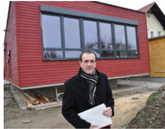
Mit den Arbeiten im Kindergarten „Sonnenhaus“ voll im Zeitplan. Während der Osterferien soll übersiedelt werden, damit auch der Altbau saniert werden kann. Der zuständige Stadtrat Bernhard Huemer ist mit den Fortschritten auf der Baustelle sichtlich zufrieden.
