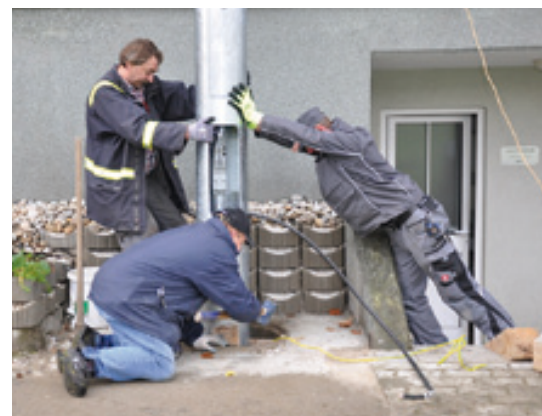
Eine leistungsfähige Flutlichtanlage, in der Oberösterreich-Liga einfach Voraussetzung für einen problemlosen Spielbetrieb! Die Freistädter Fußballer haben nun eine, weil auch die Vereinsmitglieder fleißig mitgeholfen haben. (Foto: E. Pramhofer)
